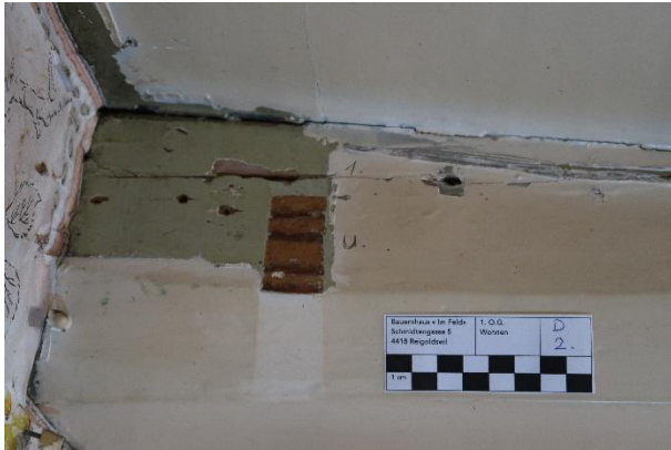
Sondierung Deckenbalken
