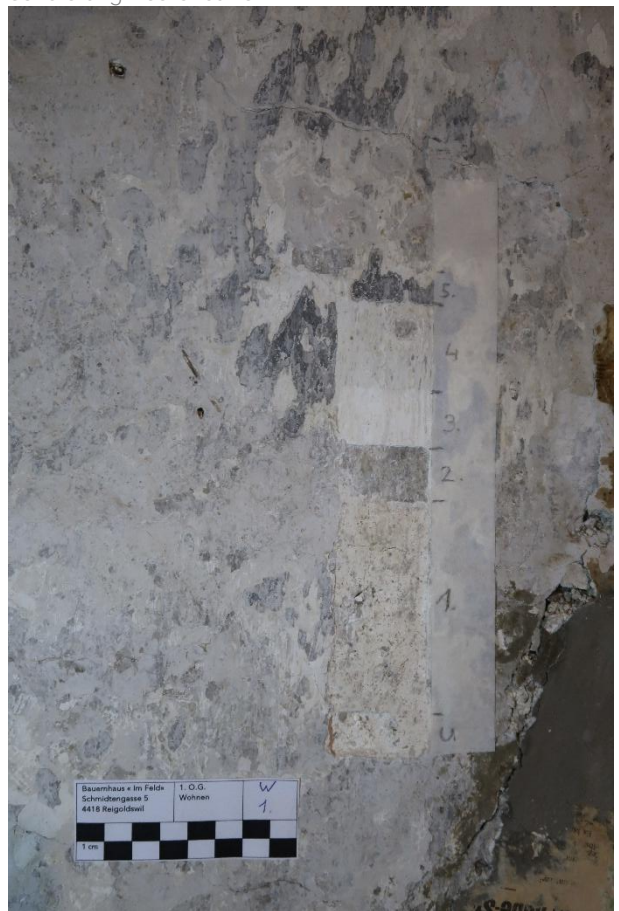
Sondierung Wand (Kalktünchen)
